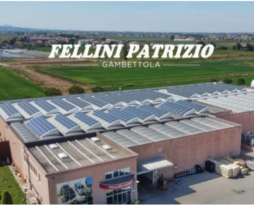
Figura 2 Impianto fotovoltaico sul tetto dello stabilimento di Gambettola
